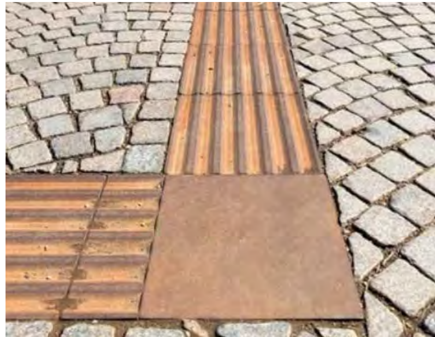
Exempel på ledstråk "PICTOLINE" och "VAL" från GH FORM. Gjutjärn.
