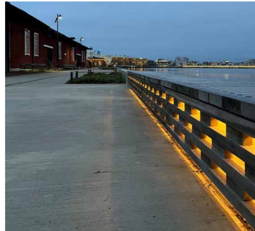
Ljus kan i utvalda lägen integreras i konstruktioner såsom lekutrustning och sittmöbler. (bildkälla: Projektteknik Ljus)
